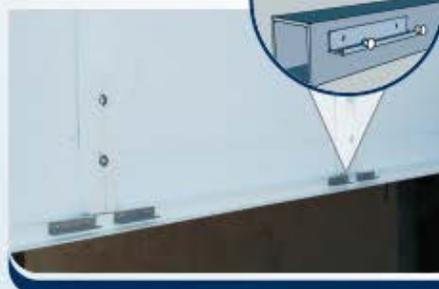
**2** Garras de inox aplicadas na parte inferior da estrutura. No detalhe, fixação de garra.
